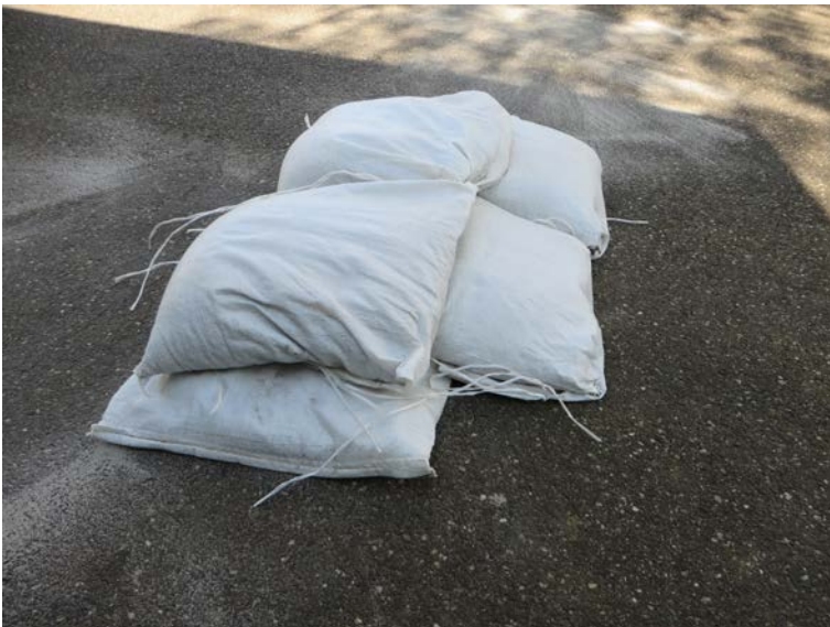
Abb. 11b: Beginn eines Sandsacknotdammes
