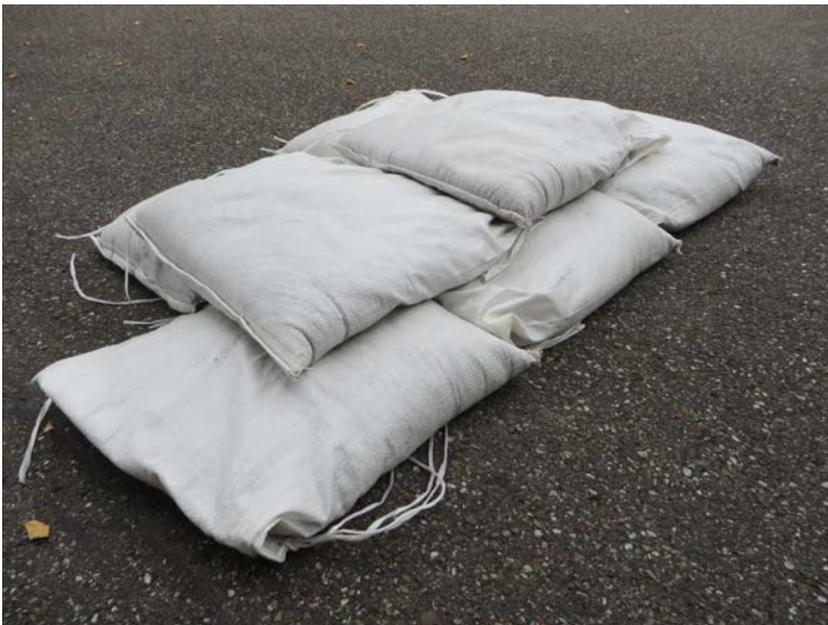
Abb. 10b: Beginn eines Sandsackdammes
