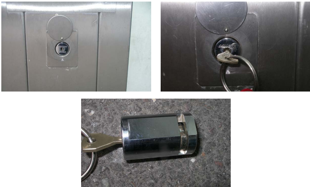
Bild 27, 28 und 29: Herausnehmen des Stahlzylinders beim genormten FSE
