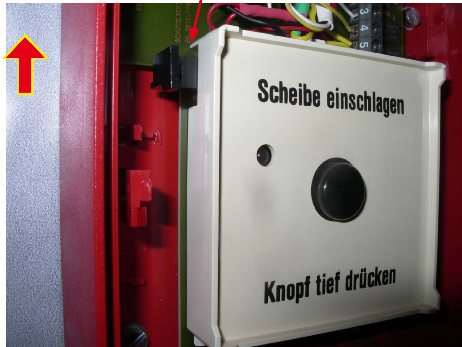
Bild 21: geöffneter Handfeuermelder
