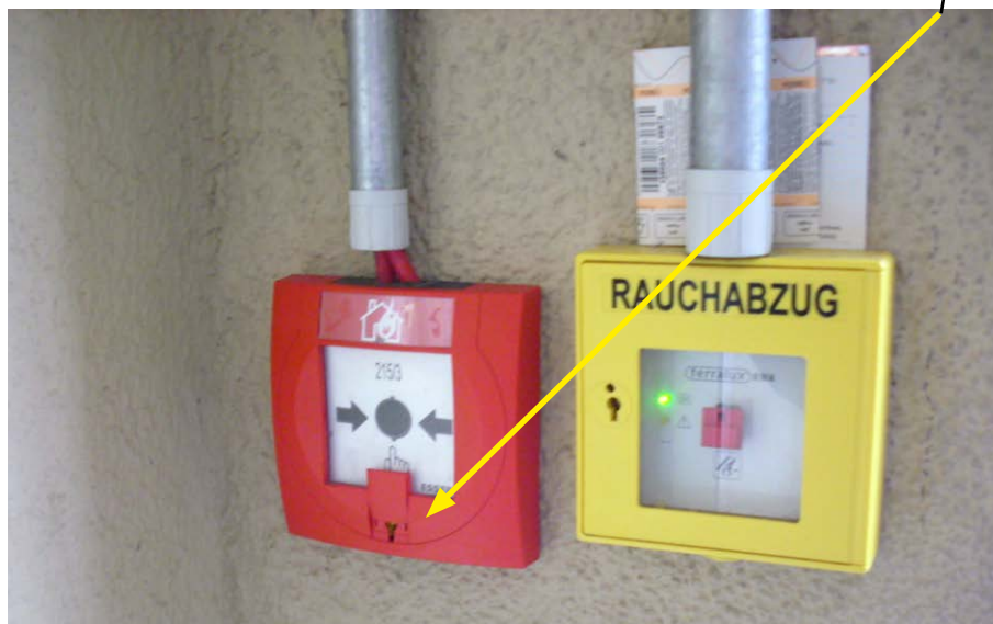
Bild 22: Meldergehäuse neuerer und herkömmlicher Bauart
