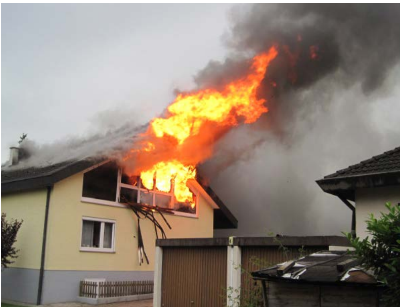
Abbildung 8: Große Flammenverlängerung bei einem Dachstuhlbrand, hierbei kann es zur erheblichen Ausbreitungsgefahr für die Nachbargebäude kommen
