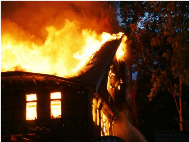
Abbildung 15: Einstürzende Giebelwand bei einem Dachstuhlbrand
