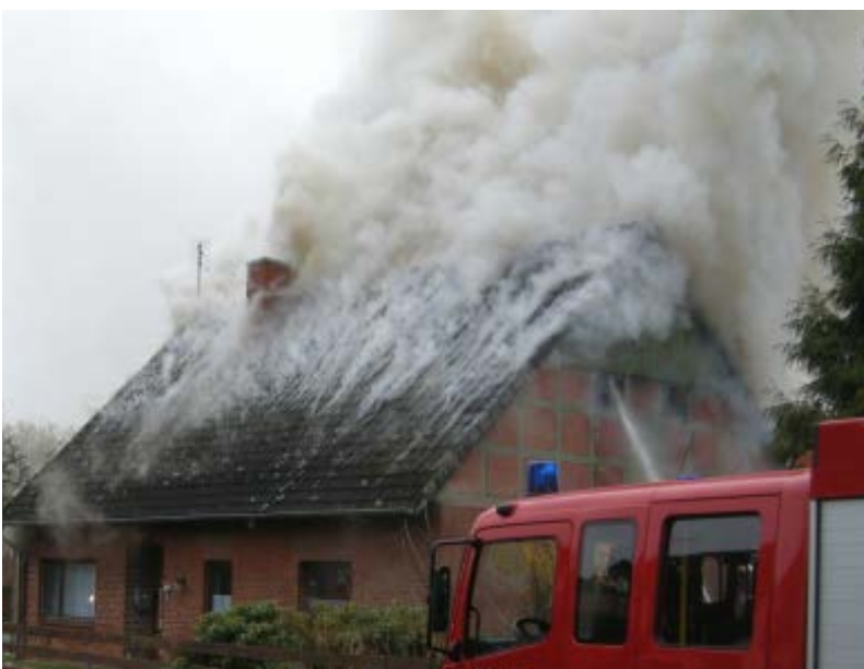
Abbildung 5: Typische Rauchentwicklung als Anzeichen eines bevorstehenden Aufbrennens des Dachstuhls
