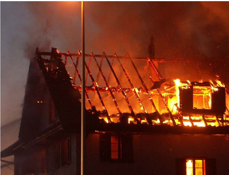
Abbildung 11: Deutlich ist das sich im Treppenraum nach unten hin ausbreitende Feuer zu erkennen
