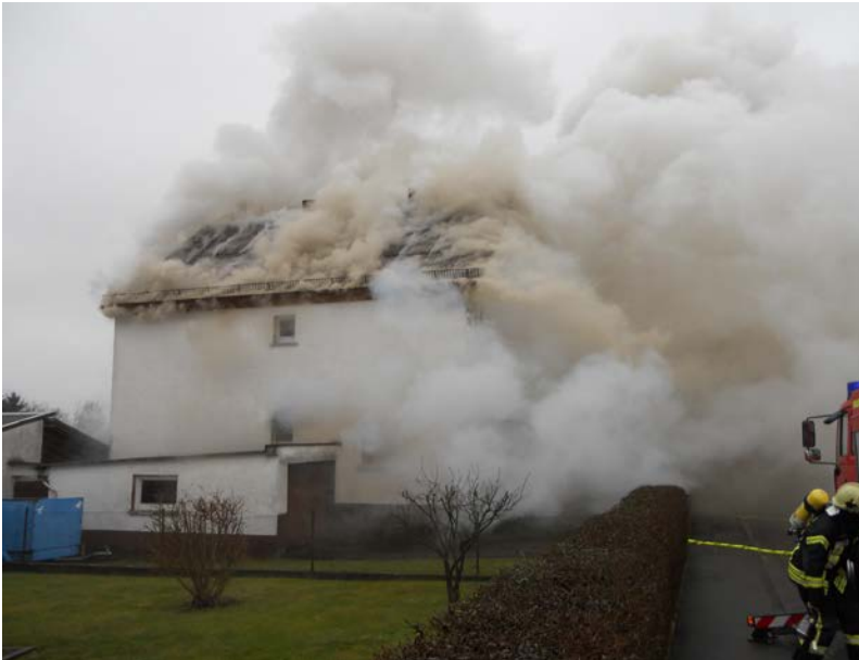
Abbildung 9: Turbulenter Rauch mit einer Braun-/Gelbfärbung – ein Hinweis auf die Pyrolyse von Holz – kurz vor der Rauchgasdurchzündung des hölzernen Dachstuhls
