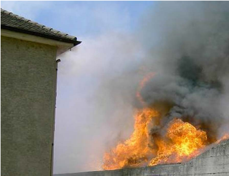
Abbildung 12: Gefahr der Ausbreitung durch Wärmestrahlung – eine leichte Rauchentwicklung ist im Bereich des Dachvorsprungs bereits erkennbar
