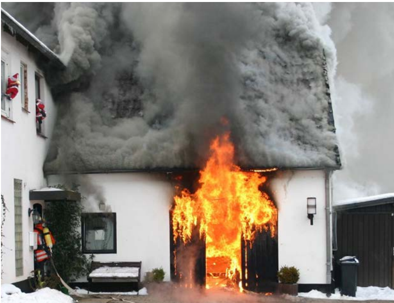
Abbildung 6: Das Feuer im Erdgeschoss hat sich schon auf den Dachstuhl ausgebreitet; dieser steht kurz vor dem Aufbrennen Quelle: Freiwillige Feuerwehr Bassum
