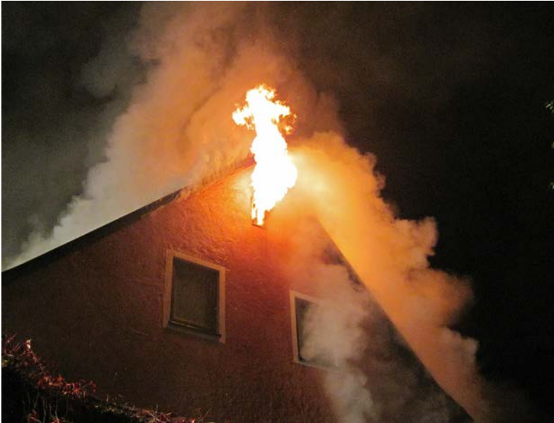
Abbildung 7: Kleinere Flammenverlängerung aus einem Giebfenster
