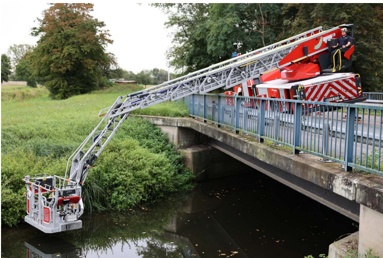
Abbildung 25: Unterflurbetrieb mit angewinkeltem Gelenkteil
