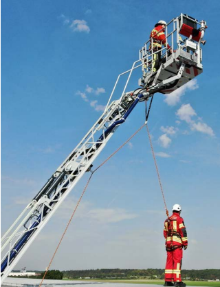
Abbildung 22: Absturzsicherung z. B. bei Arbeiten auf Dächern
