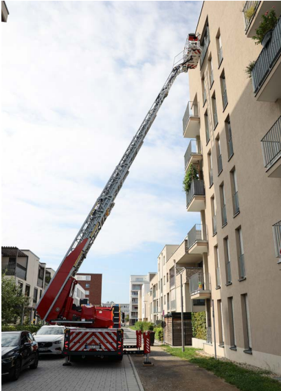
Abbildung 35: Erreichen von Anleiterstellen durch genaue Positionierung
