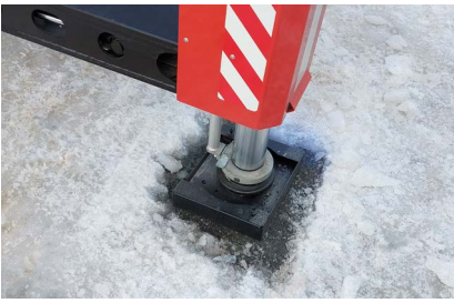
Abbildung 40: Vereister Untergrund muss vor dem Abstützvorgang eisfrei gemacht werden.
