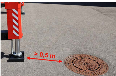
Abbildung 37: Abstützung auf einem festen tragfähigen Untergrund (Asphalt) unter Beachtung des Mindestabstands von 0,5 m zu Schachtdeckeln
